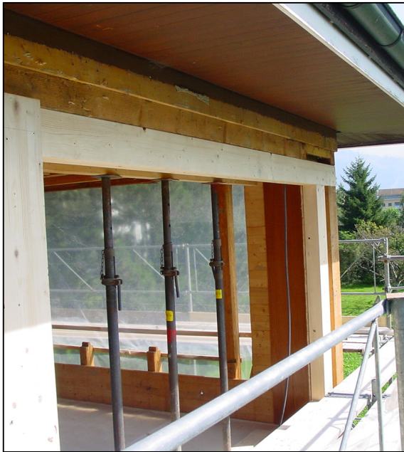
Fig. 2.6: Enlarging/adding window area, 411APT Stanssted CH (photo: Beda Bossard Büro für Baubiologie, Bauökologie & Energie)
